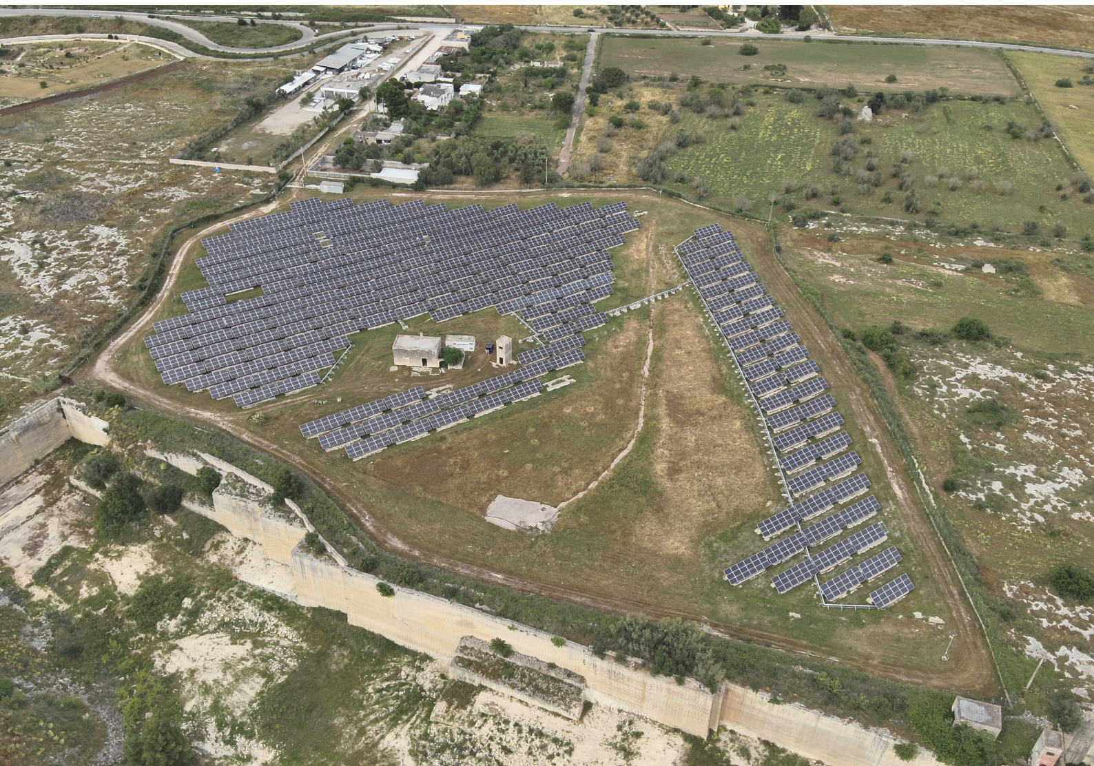
Impianto Masseria del Sole - Puglia (ex discarica bonificata)
